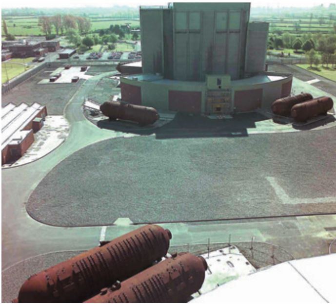
Réacteur MAGNOX de Berkeley – état d'entreposage sûr
