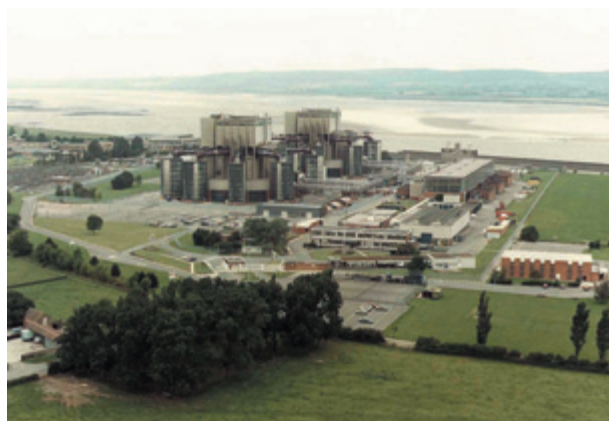
Réacteur MAGNOX de Berkeley – état initial
